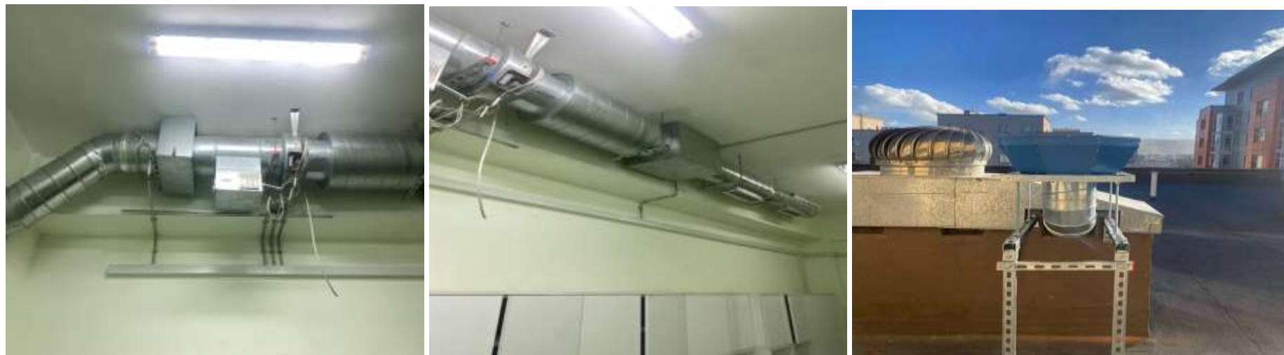
17 Салбар эмнэлгийн түлэнхийн тасгийн бохир боолтын өрөөнд өгөх сорох агааржуулалтын тоноглол суурилуулж агаар сэлгэлтэй болгов.
