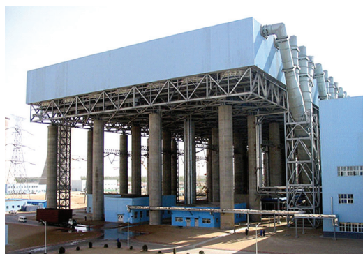
Дулааны цахилгаан станцын агаарын хуурай хөргүүр станц
